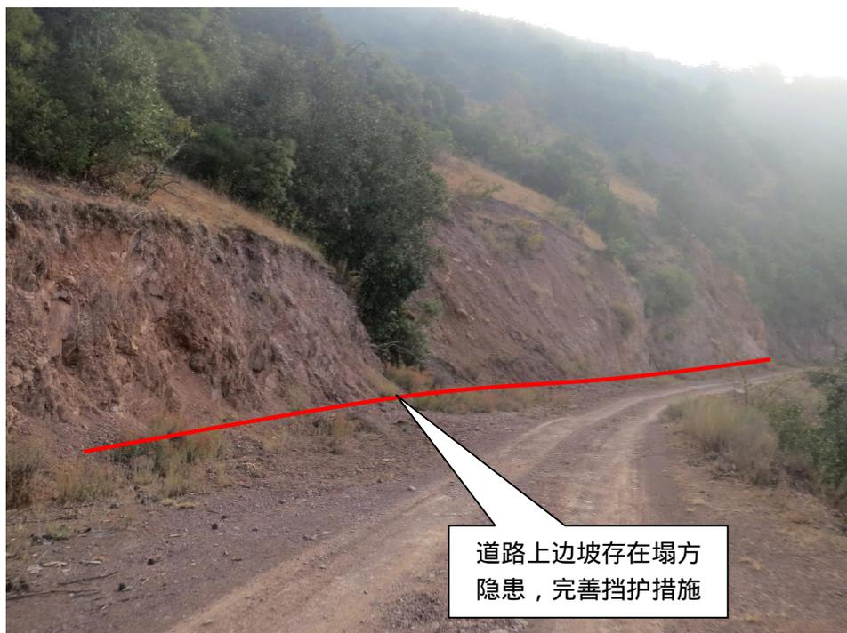
图 10：进场道路高边坡完善拦挡典型示意 2
