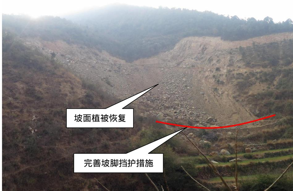
图 5：渠道下边坡典型完善示意 1
