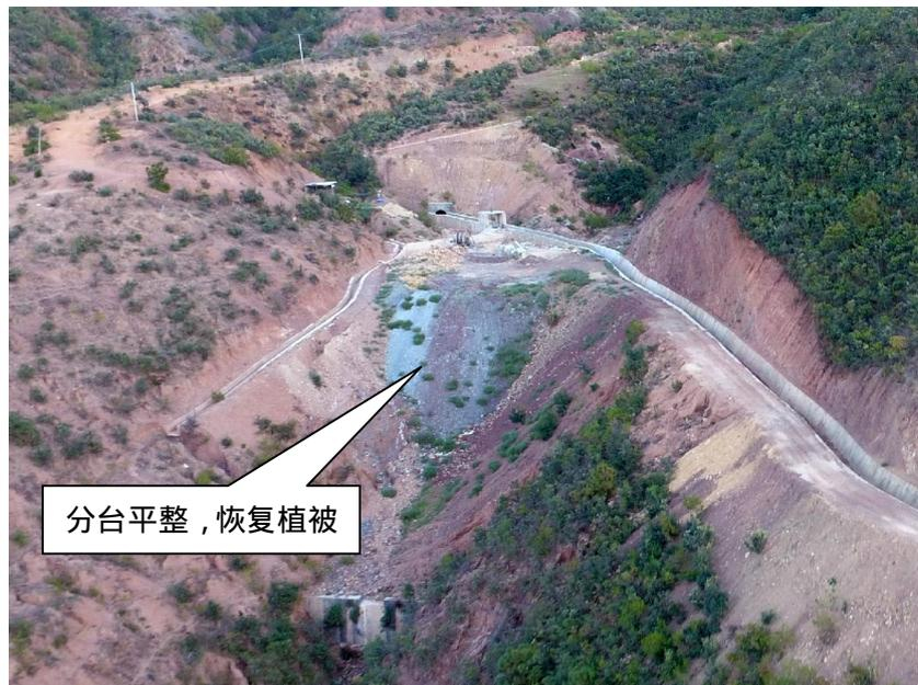
图 19：老尖山隧洞入口处弃渣场完善示意
