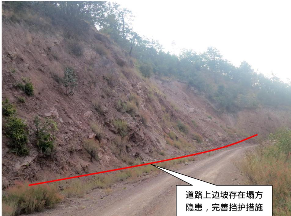
图 9：进场道路高边坡完善拦挡典型示意 1
