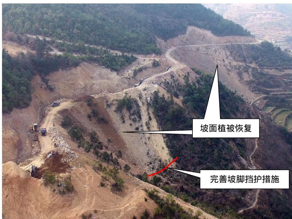
图 6：渠道下边坡典型完善示意 2
