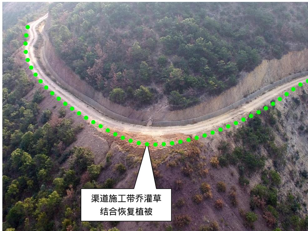
图 7：渠道施工带植被恢复示意
