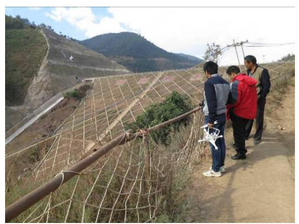
向业主了解工程进度情况
