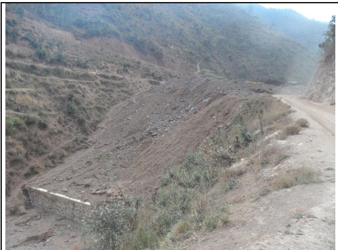
完善 1#弃渣场外围截水沟、坡面分台、绿化（2016 年 3 月）
