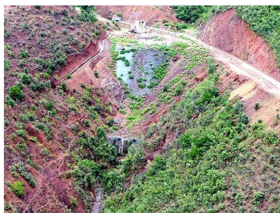
7#弃渣场-老尖山隧洞入口（2017.7）
