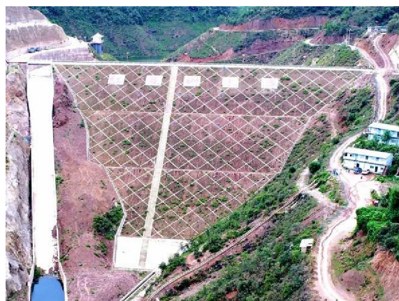
枢纽区大坝现状（2017.7）
