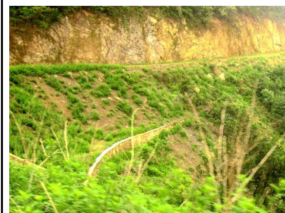
道路下边坡浆砌石挡墙
