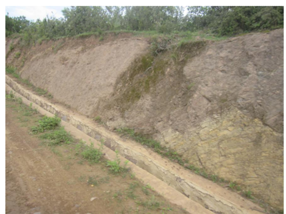
进库公路排水沟
