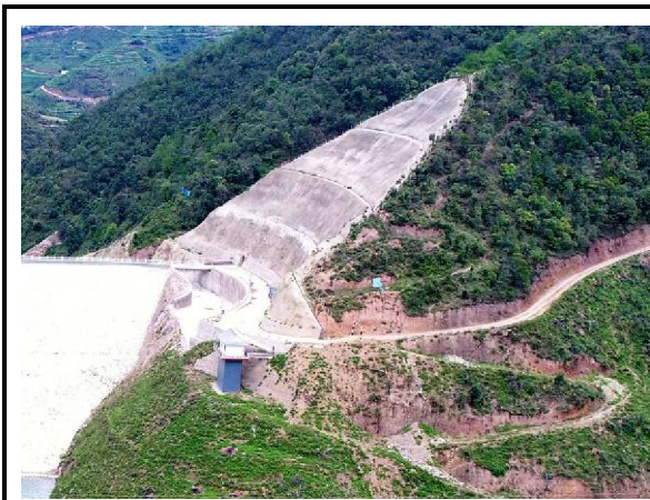
枢纽区喷砼护坡
