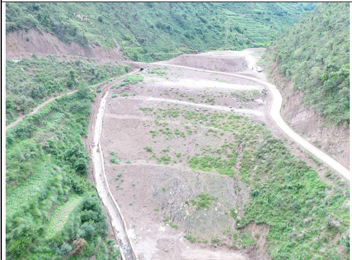
1#弃渣场外围截排水、坡面分台、绿化（2017 年 7 月）
