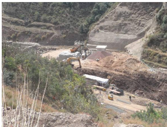
枢纽区临时施工营场地（2016.3）
