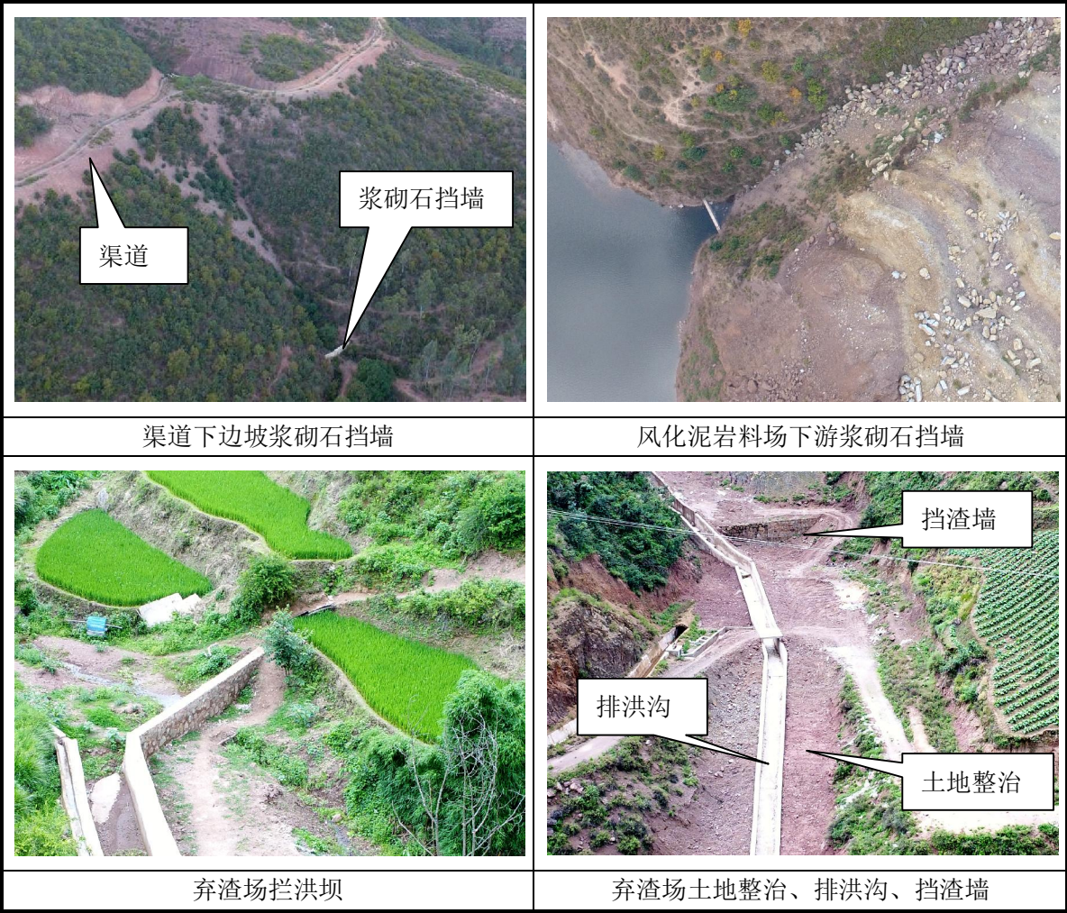
图 4-1 部分水土保持工程措施示意图
