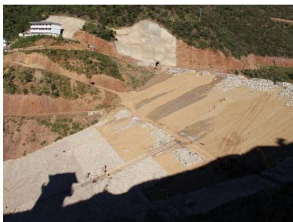
枢纽区大坝现状（2015.10）
