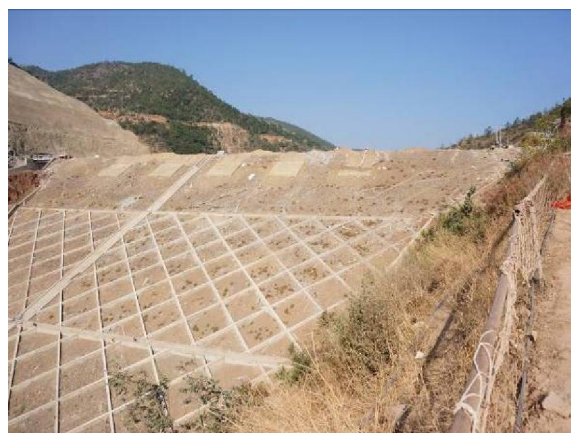
枢纽区大坝现状（2016.3）
