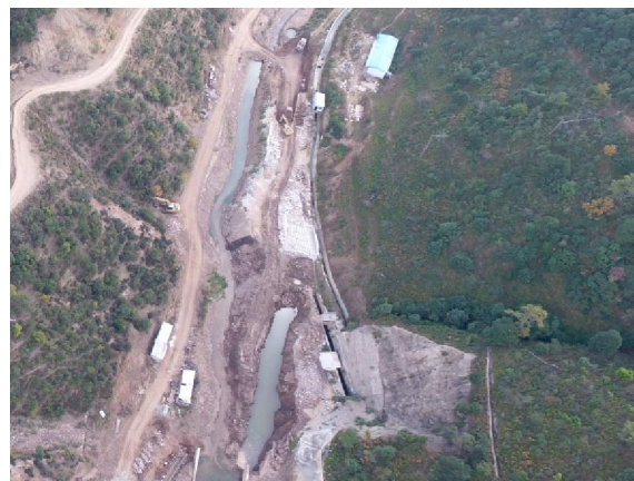
枢纽区临时施工营场地（2016.12）
