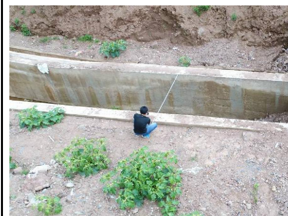
弃渣场排洪沟尺寸测量
