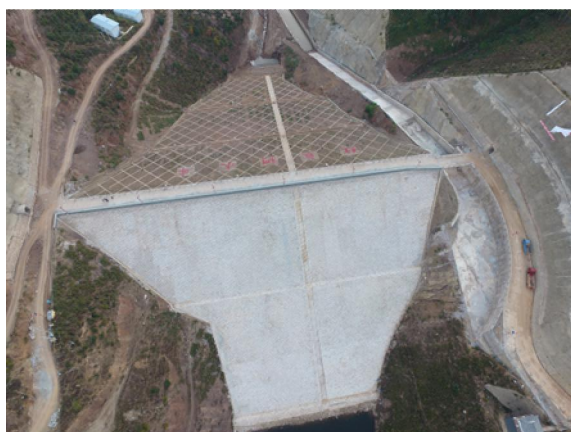
枢纽区大坝现状（2016.12）
